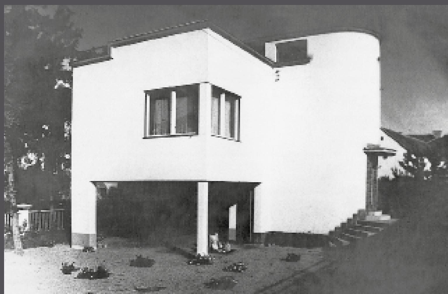
Építészetének egyik legszebb megnyilvánulása az 1933-ban felépült saját lakóháza, aszimmetrikus szerkesztésű, lapostetős modern villa a Várkörút II. sz. alatt.
