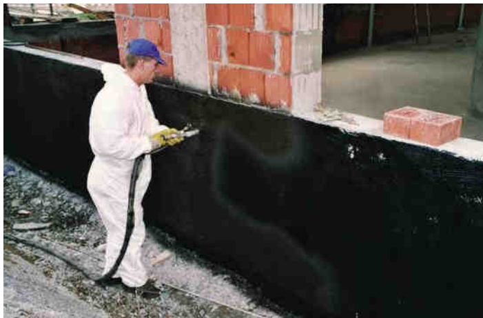
A Plastimul szigetelő habarcsok arra alkalmas géppel szórhatóak, így a munka termelékenysége tovább fokozható.
