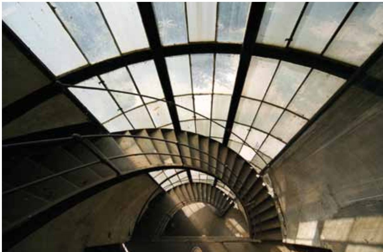
Reich Kálmán és Birbauer Virgil által 1913–1933 között terve- zett Kelenföldi Erőmű épülete
