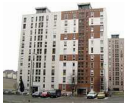
Vitatható megoldás: egyedi külső oldali hőszigetelés
