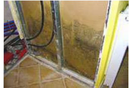
Burkolat mögötti penész Forrás: daemmen und sanieren.de
