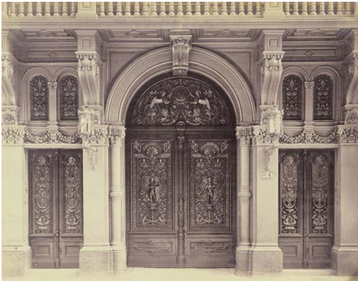
Az épület főbejárata a Széchenyi utca felől nyílt. A gazdagon díszített kapuzatot Klösz György 1880-as években készült fotója őrizte meg számunkra. Forrás: BFL XV.19.d.
